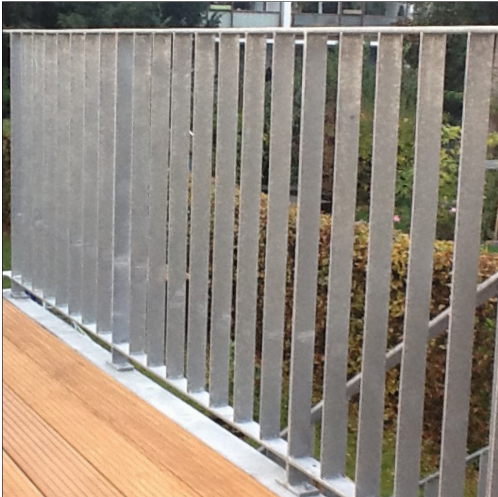
Staketengeländer 50/10 Stahl, feuerverzinkt Lt. Schlosserplan 1706
